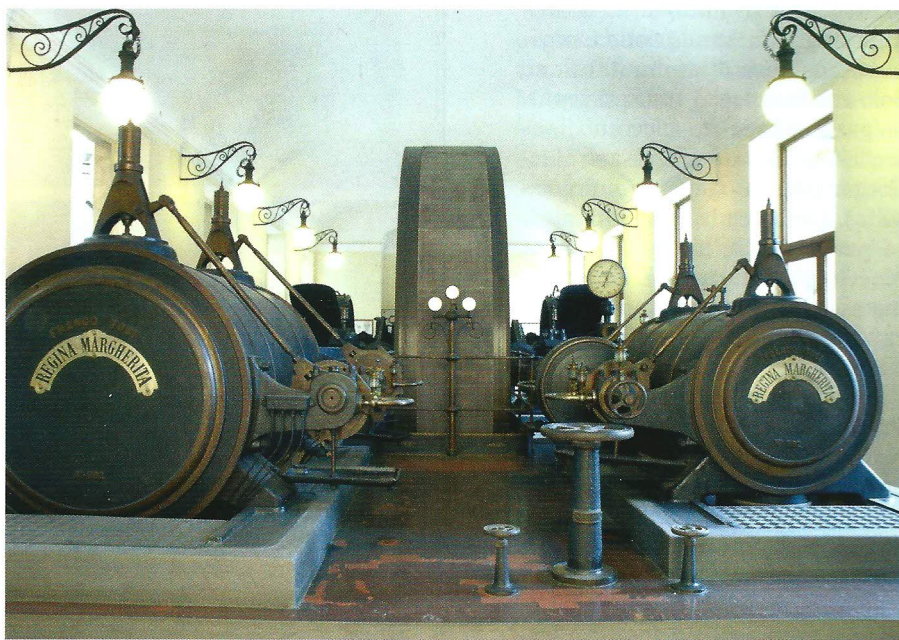
Centrale Termoelettrica "Regina Margherita": installata nel setificio Egidio e Pio Gavazzi di Desio (MI), forniva corrente elettrica per l'illuminazione degli ambienti e per il funzionamento di milleottocento telai. [© Museo Nazionale della Scienza e della Tecnologia - MI]
